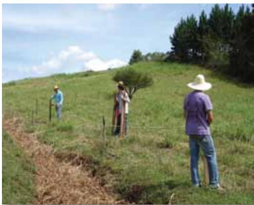
Construção da URT/divisão de área
