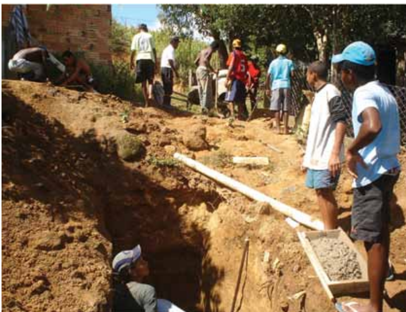
Mutirão para a construção de sistema de tratamento de dejetos
