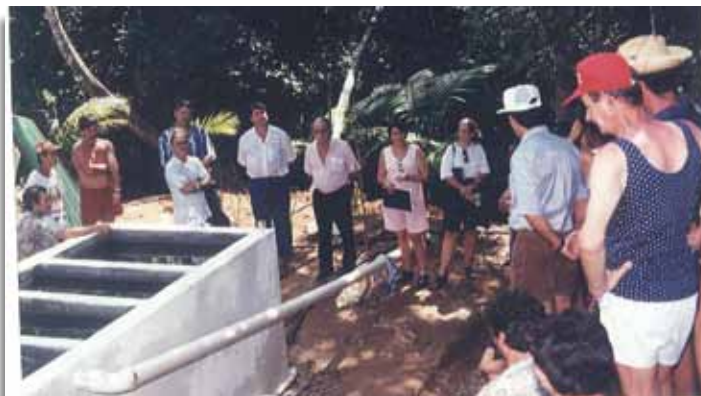
Sistema de tratamento de água – caixa de filtragem
