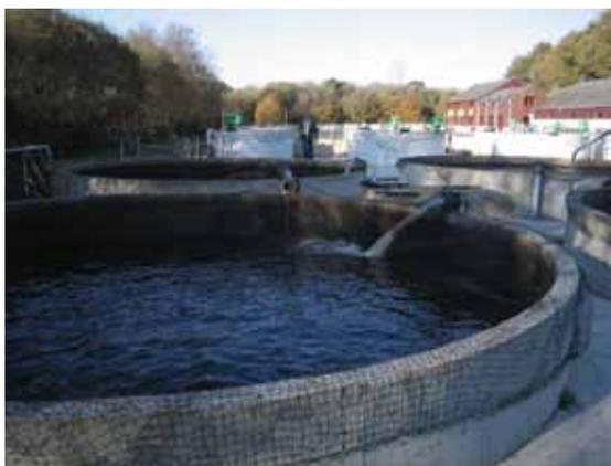
Figura 2. Tanque circular de concreto, coberto com rede
