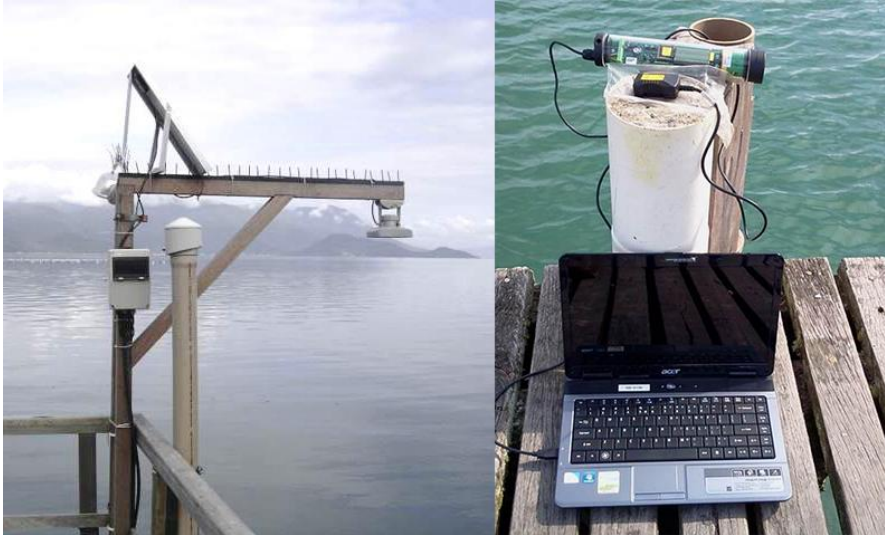
Figura 6. Dois modelos de marégrafos utilizados no projeto: à esquerda, um marégrafo com sensor tipo radar; à direita, um marégrafo que utiliza sensor com boia e contrapeso
