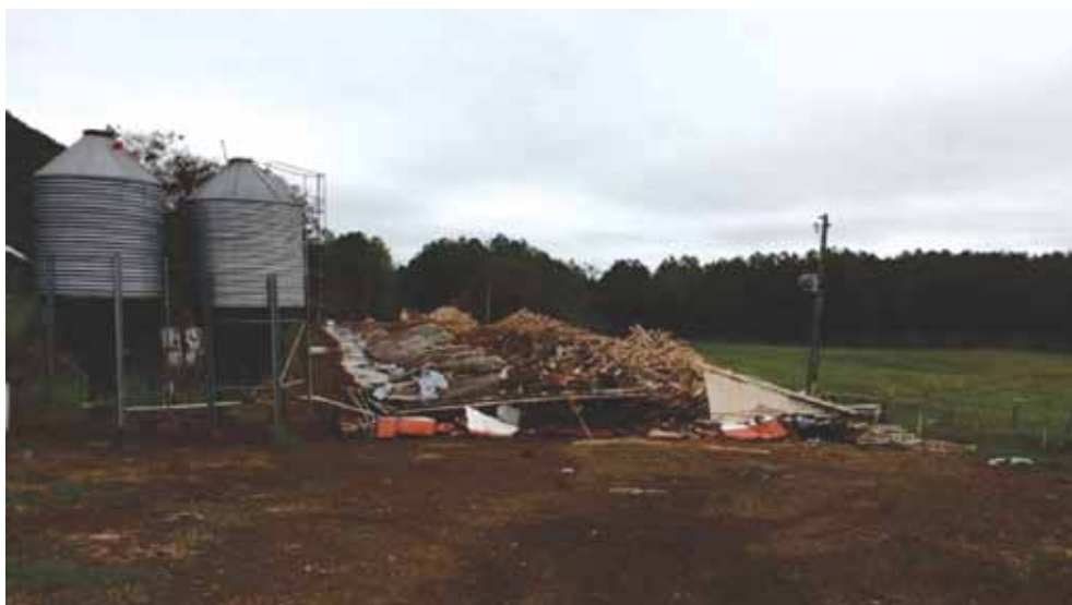
Figura 6. Destruição causada em aviário – município de Tangará
