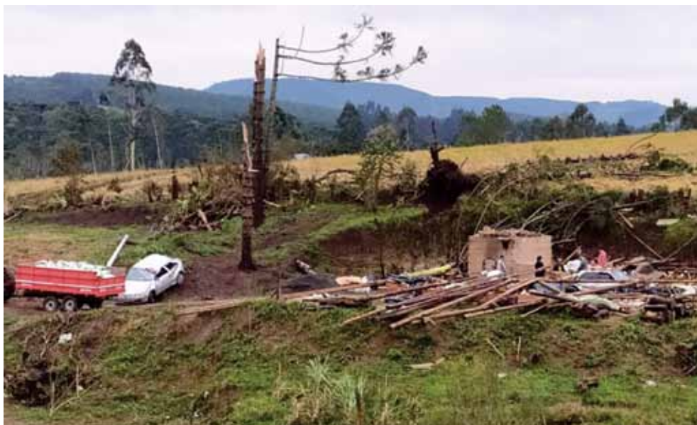
Figura 5. Destruição causada em residência e outros danos ao estabelecimento – município de Irineópolis
