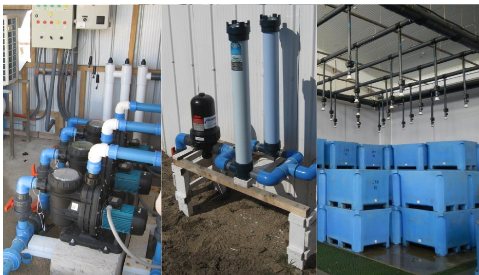
Figura 17. Exemplos de estruturas e equipamentos usados para a captação, tratamento e distribuição de água. Da esquerda para a direita: bombas hidráulicas; sistema de filtragem e equipamento de desinfecção de água por luz ultravioleta; encanamento para distribuição de água para tanques de depuração
