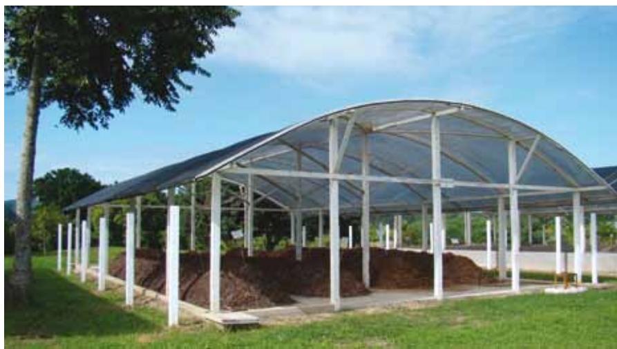
Figura 1. Leiras de matéria-prima em processo de compostagem em abrigos cobertos por polietileno e com piso de concreto
